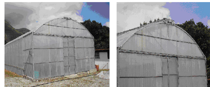
Fig. 7 Invernadero ubicado en el Instituto de Investigaciones Agropecuarias, Sector Santa Rosa, Mérida, Estado Mérida. (a) Invernadero con ventana cenital cerrada (b) Invernadero con ventana cenital abierta
