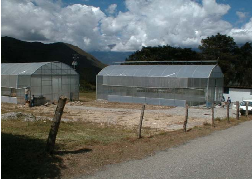
Figura 12. Invernadero de tecnología italiana (CO.SER.), modelo ala de gaviota, con apertura cenital y control automatizado, en función de la temperatura.
