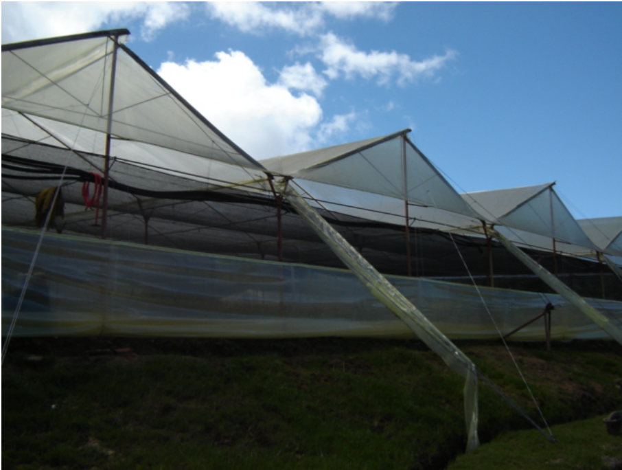
Figura 10. Estructuras a dos aguas. Laterales con film plástico por fuera y malla en el interior Lugar: La Carbonera
