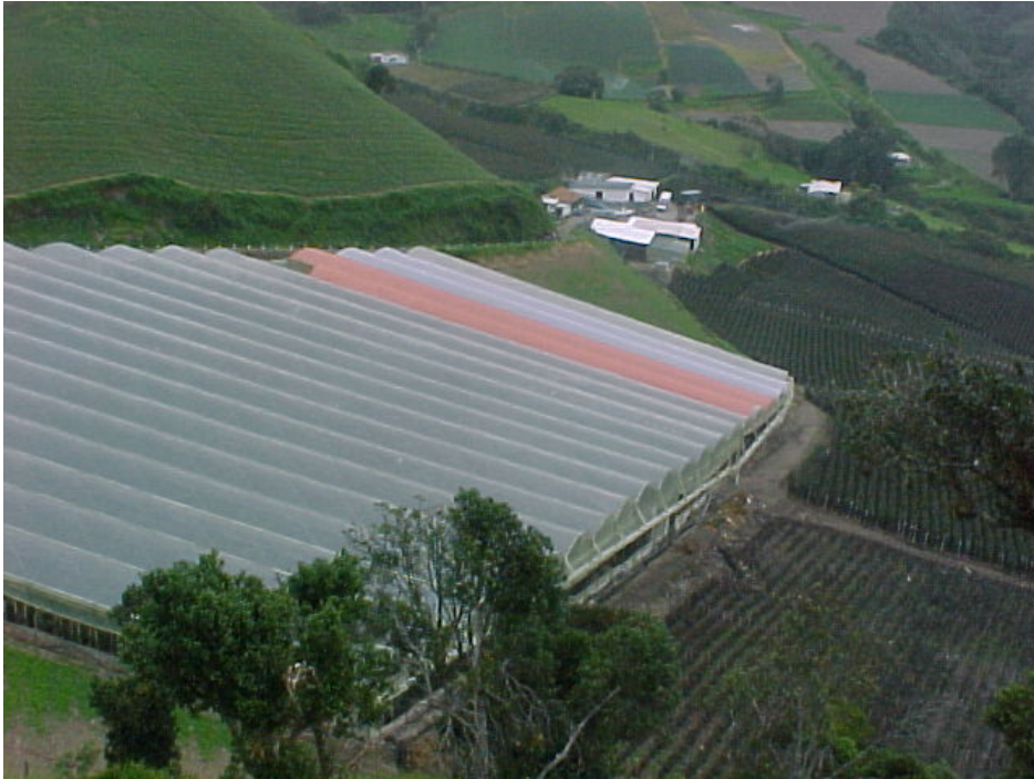
Figura 6. Instalaciones elaboradas con tubos y sistema de ventilación tubular. Lugar: Las Tapias.
