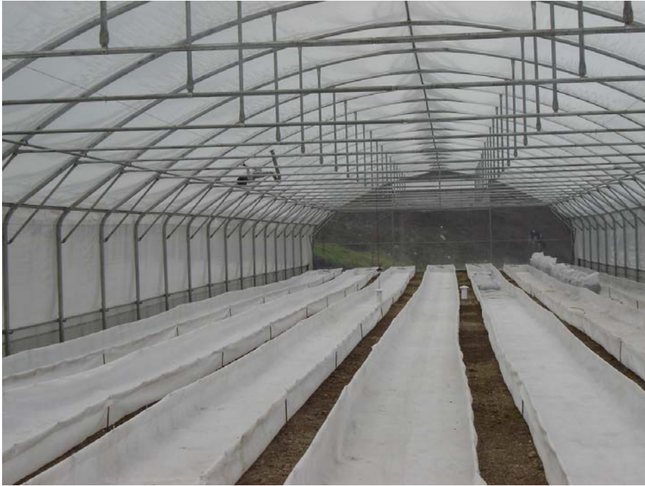
Figura 13. Invernadero de tecnología francesa, marca Richell. Presenta doble techo de película plástica, para formar un colchón de aire entre las dos capas del film de cubierta (utiliza un compresor), lo que constituye una estructura aislante térmica, evitando los daños causados por las heladas. Además poseen sistemas automatizados para la apertura de las cortinas laterales. Lugar: Mucuchies, sector Angostura.
