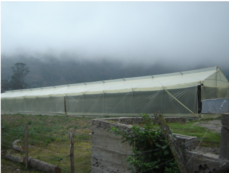
Figura 7. Invernadero construido con tubos y sistema de ventilación tubular con apertura cenital fija. Lugar: Bailadores
