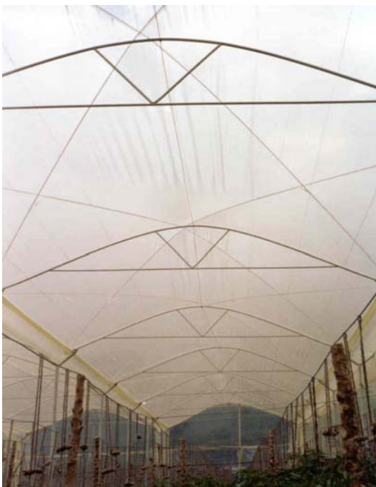
Figura 5. Estructuras con tubo y ventilación tubular. Con guayas por encima de la cubierta plástica.
