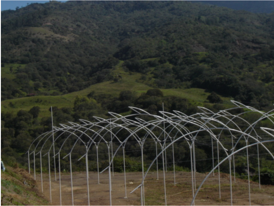
Figura 8. Detalles de instalaciones con tubo y sistema de ventilación tubular. Lugar: La Carbonera
