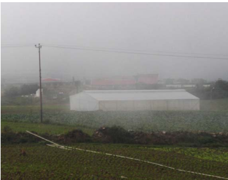
Figura 11. Invernadero-propagador, estructura galvanizada. Apertura Cenital tipo chimenea. Lugar: Mesa Cerrada
