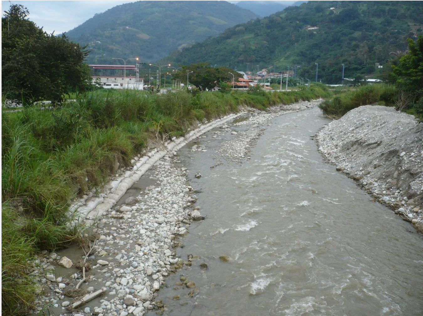
Muro longitudinal de bolsacreto en el río Mocotíes. Fotografía tomada por A. Moreno, 2012
