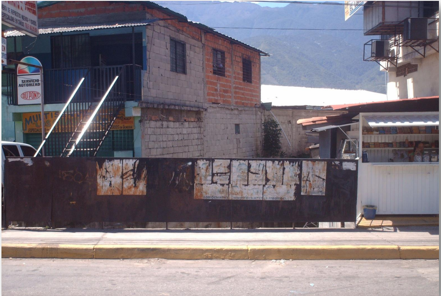
Embaulamiento de la quebrada La Resbalosa. Fotografía tomada por A. Moreno, 2011
