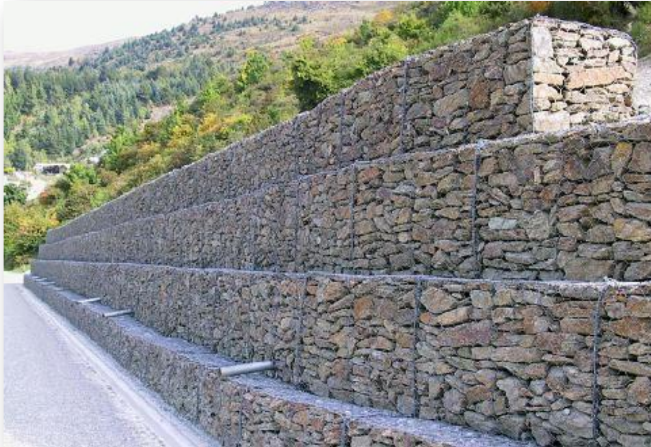
Gavi3n utilizado como muro de contenci3n
