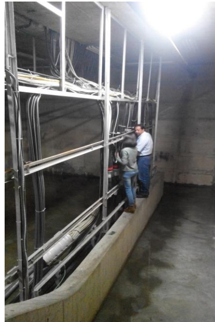
Figura 29. Sotano de la central de Ejido
