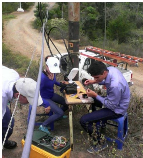
Figura 3. Empalmando fibra a pocos metros de la estación de Chiguará
