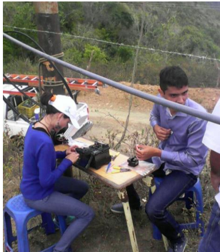
Figura 3. Empalmando fibra a pocos metros de la estación de Chiguará
