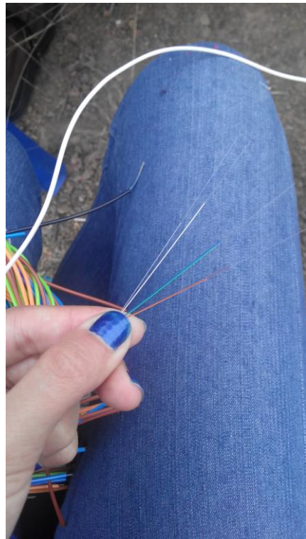
Figura 35. Mi primer corte para empalmar
