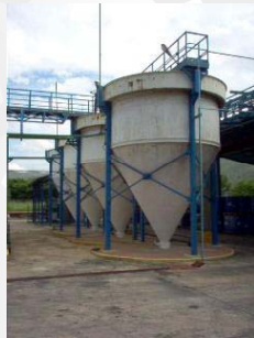
Fig. 3 Sedimentadores de Planta de Tratamiento de Aguas Residuales Industriales
