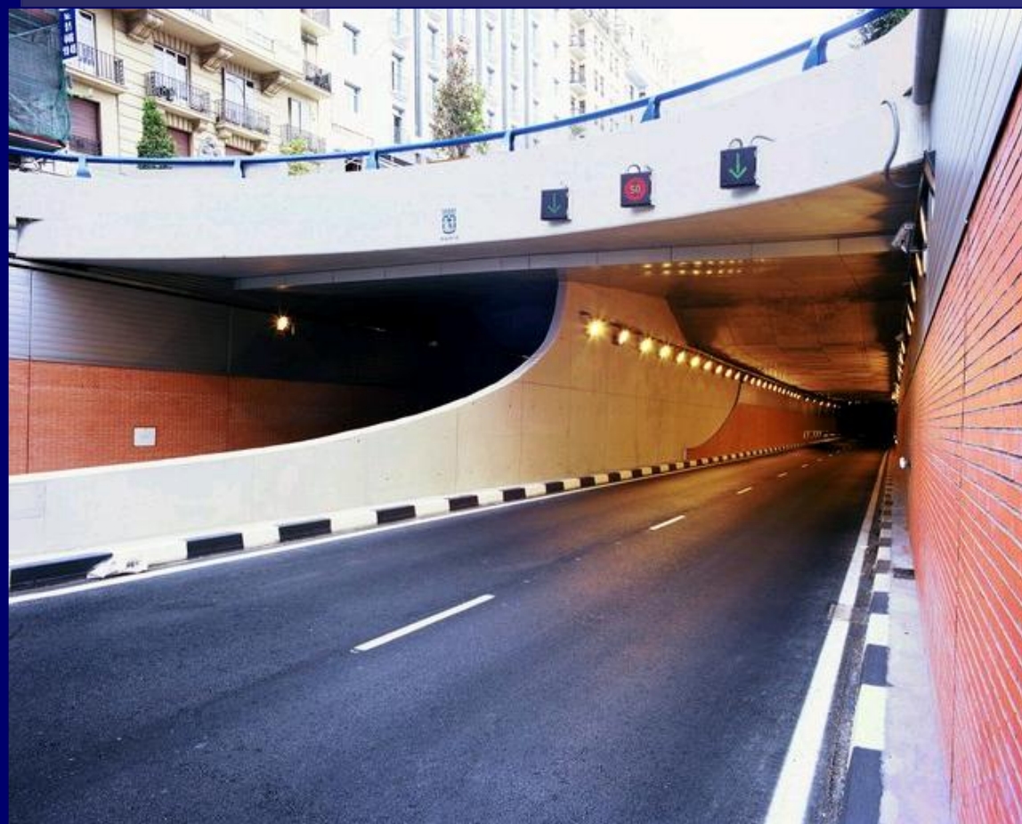
España Túnel de cuatro caminos Madrid
