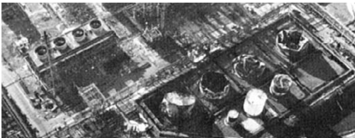
Figura 170 Explosión de una planta de craqueo con vapor para producir etileno en Holanda (1975). Se produjo por fragilidad a baja temperatura de un tanque de alimentación de nafta.
