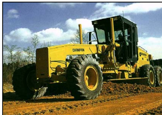
Fig. 9. Motoniveladora perfilando la explanada mejorada.
