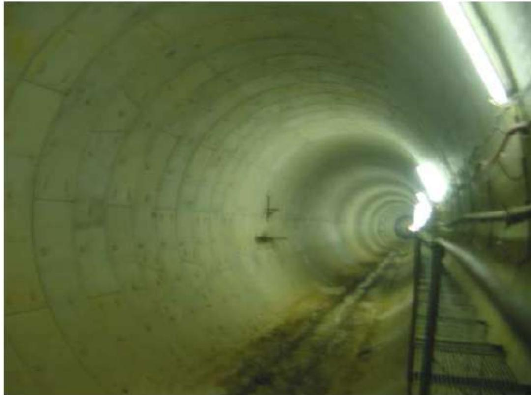
Vista interna del túnel mostrando el revestimiento definitivo
