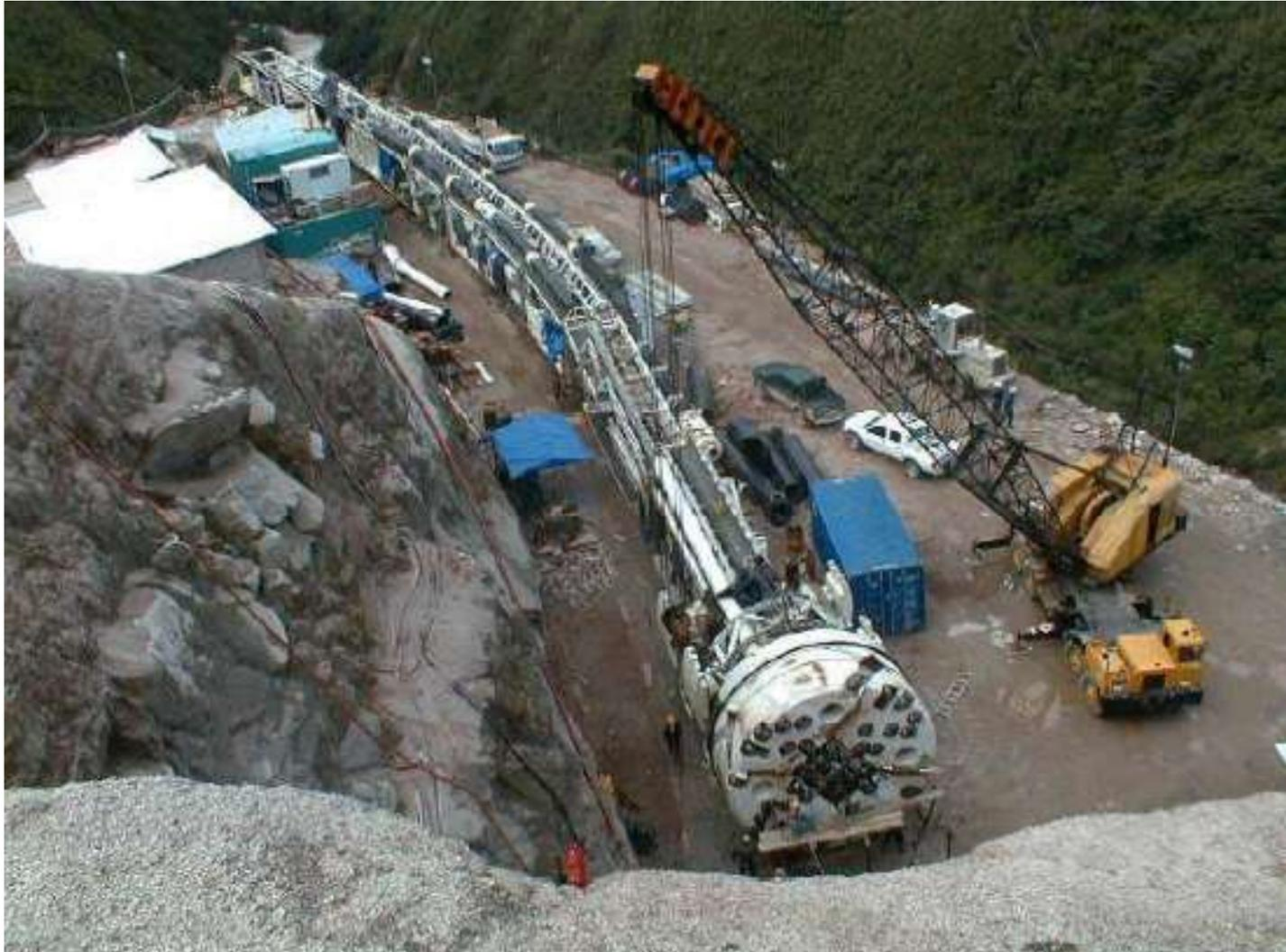
Vista general de un topo a punto de iniciar el ataque de la excavación
