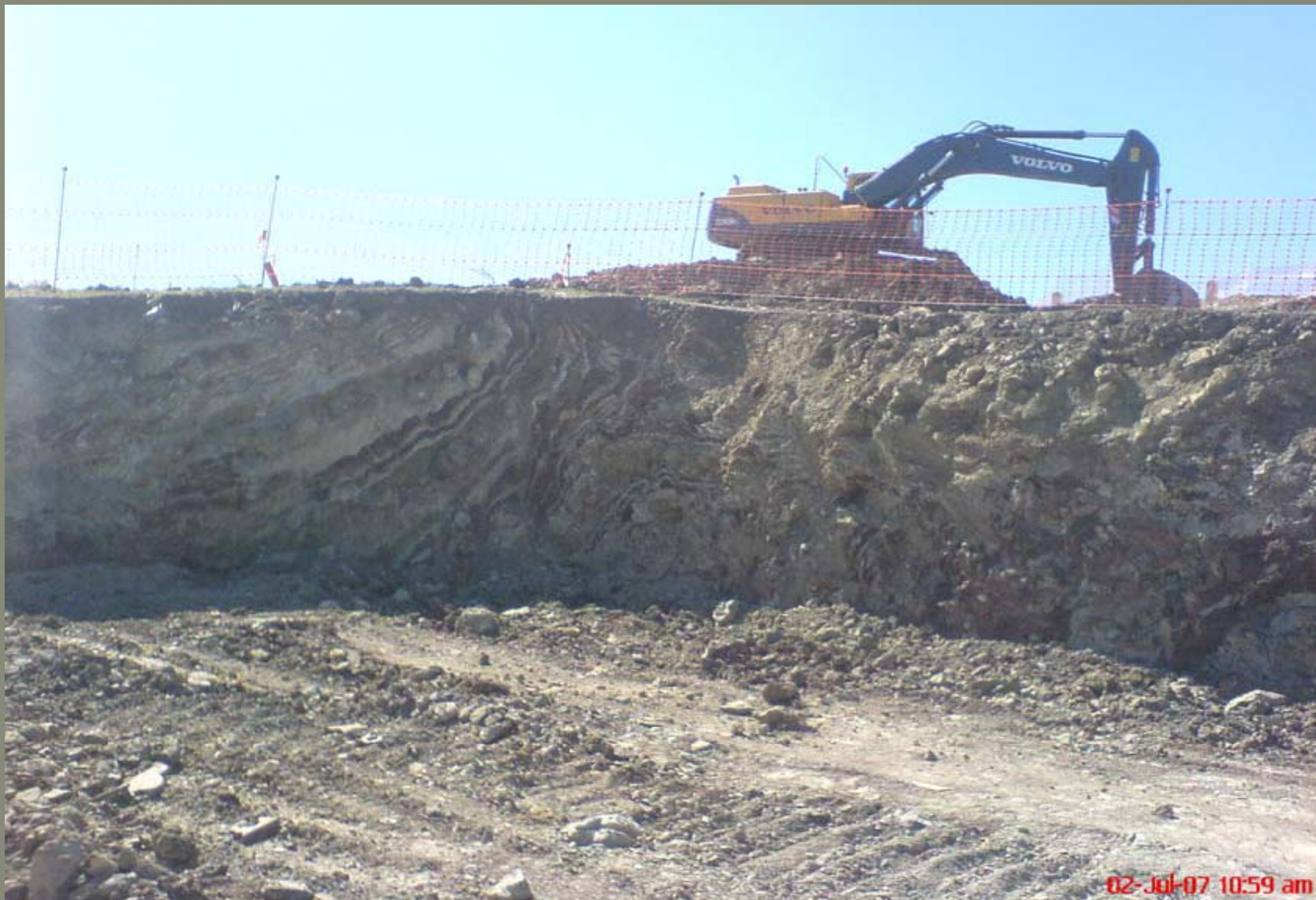
Excavación en un terreno de roca blanda
