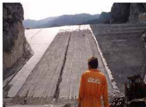
Foto 7: Presa Bovilla, Albania. Geomembrana como elemento impermeable de una presa de grava.
