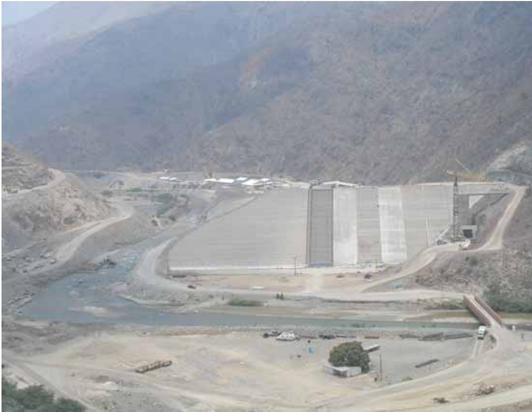
Foto 2: Presa Limón/Olmos. Construcción parcial y desvío Oct 2007.
