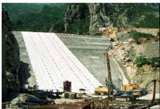
Foto 7: Presa Bovilla, Albania. Geomembrana como elemento impermeable de una presa de grava.
