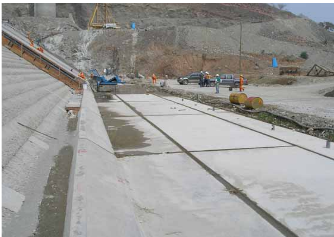
Foto 8: Presa Limón/Olmos. Brocales Zona 2, plinto, losa de conexión a diafragma y juntas.
