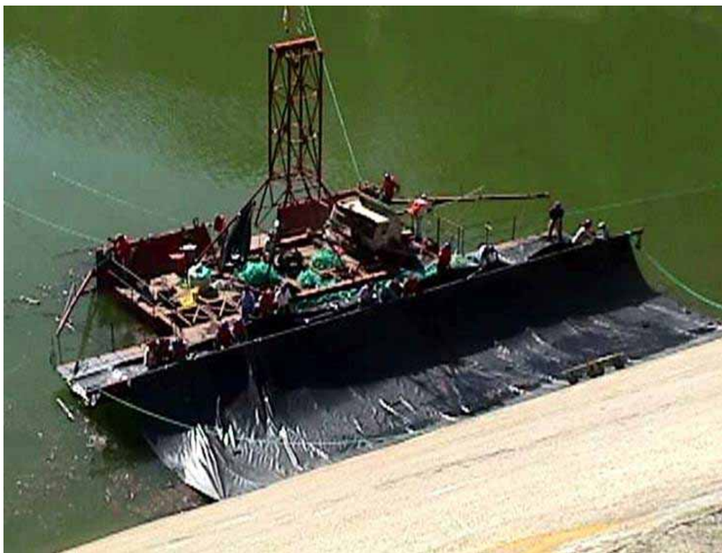
Foto 6: Presa Turimiquire. Colocación de membrana (cortesía Ing. C. Pimentel)
