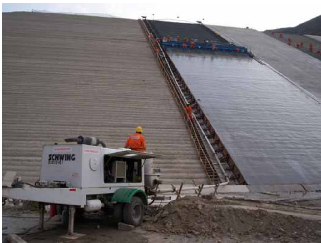
Foto 4: Presa Limón/Olmos. Vaciado de paño de losa y curado con agua.
