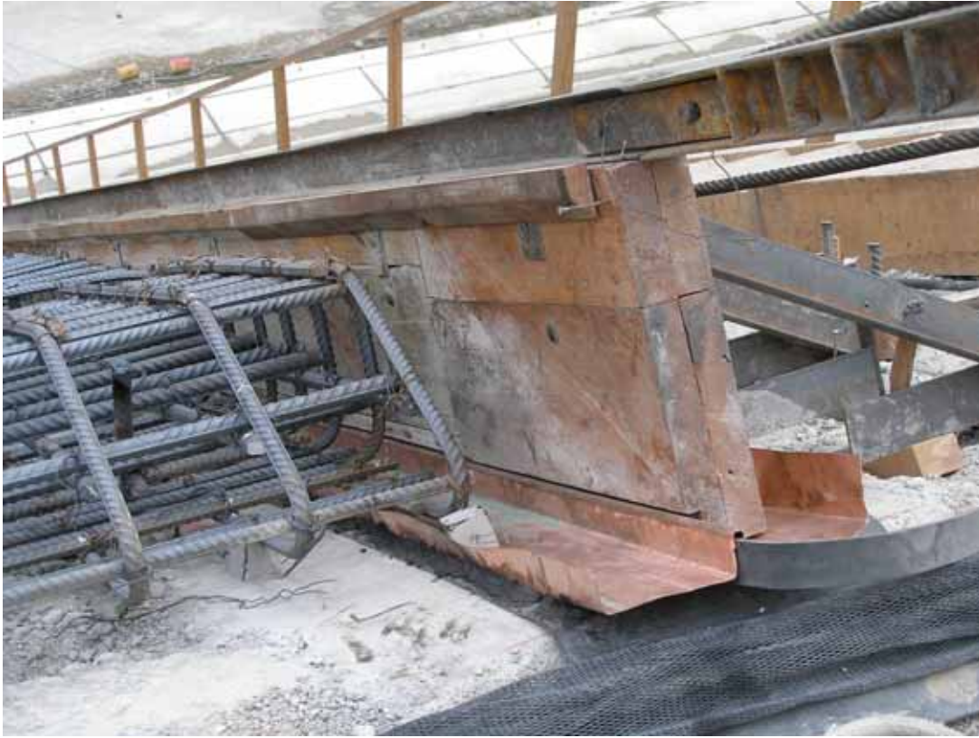
Foto 5: Presa Limón/Olmos. Detalle de junta vertical
