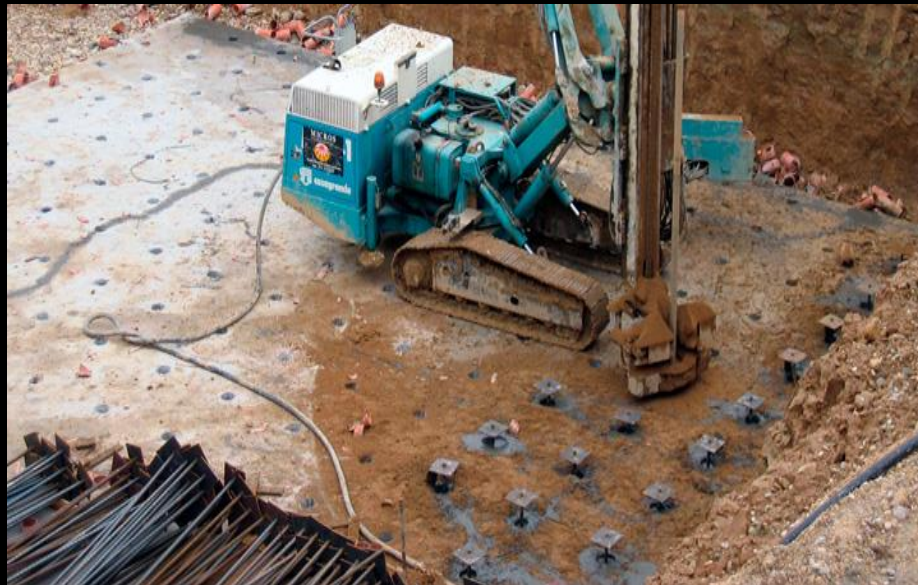
Micropilotes con anclajes
